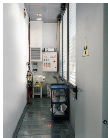
IMPIANTI RACCOLTA REFLUI INTERFACCIATO CON PC
